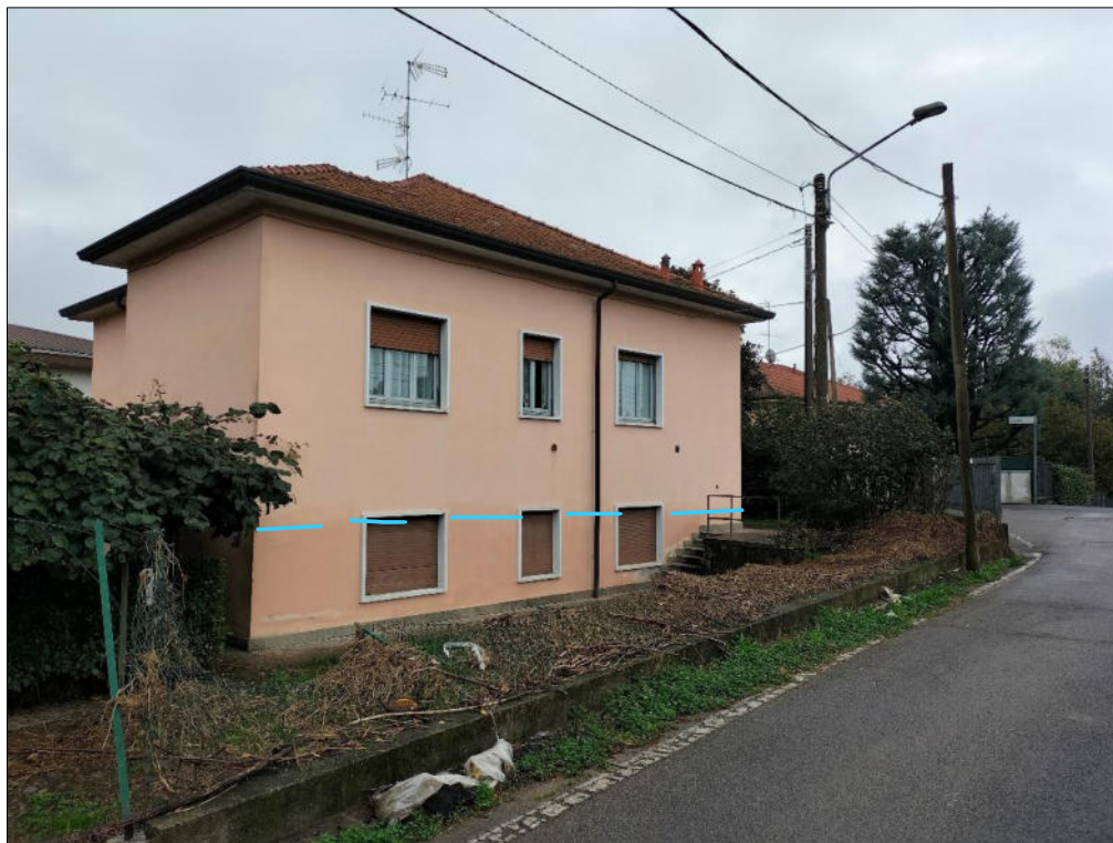
Figura 56. Abitazioni lungo via Tintoretto, dove si nota la recinzione abbattuta e il livello raggiunto dall'acqua
