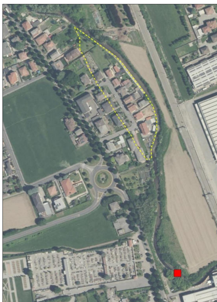
Figura 50. Identificazione (tratteggio giallo) dell'area di via Petrarca allagata il 5 luglio 2025; il quadrato rosso indica la posizione del ponte realizzato per consentire l'accesso all'area di cantiere della vasca di laminazione. La delimitazione dell'area allagata fa riferimento alle riprese aeree con drone effettuate dai VV.FF.
