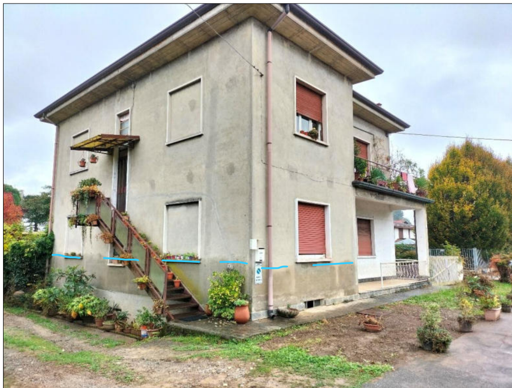
Figura 57. Abitazione lungo via Tintoretto dove si nota il livello raggiunto dall'acqua
