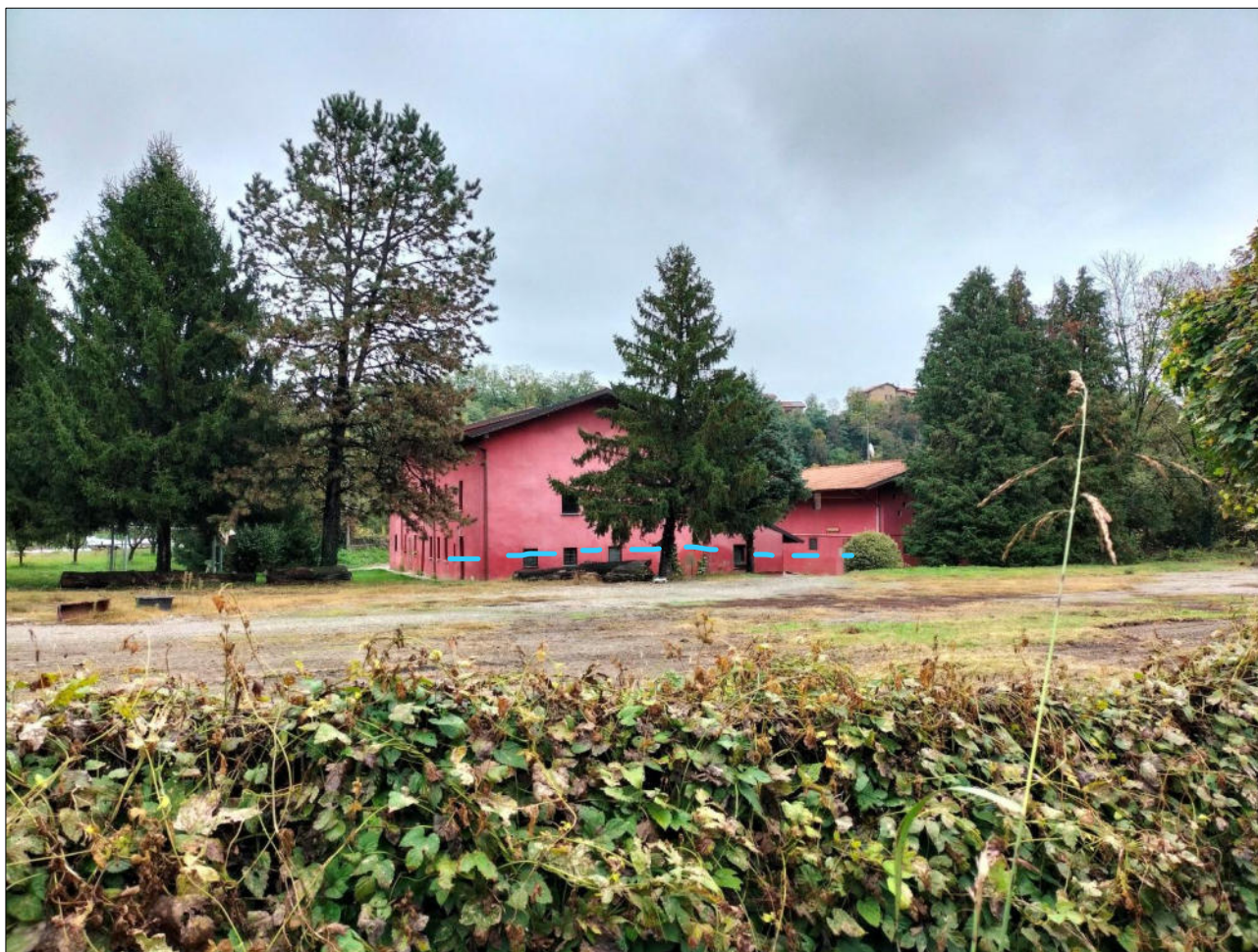
Figura 38. Località Mulino Foppa. Si nota come gli edifici risultano più bassi delle aree circostanti, come se fossero collocati in una “vasca”. Con il tratteggio azzurro è indicato il livello dell’acqua raggiunto il 22 settembre 2025
