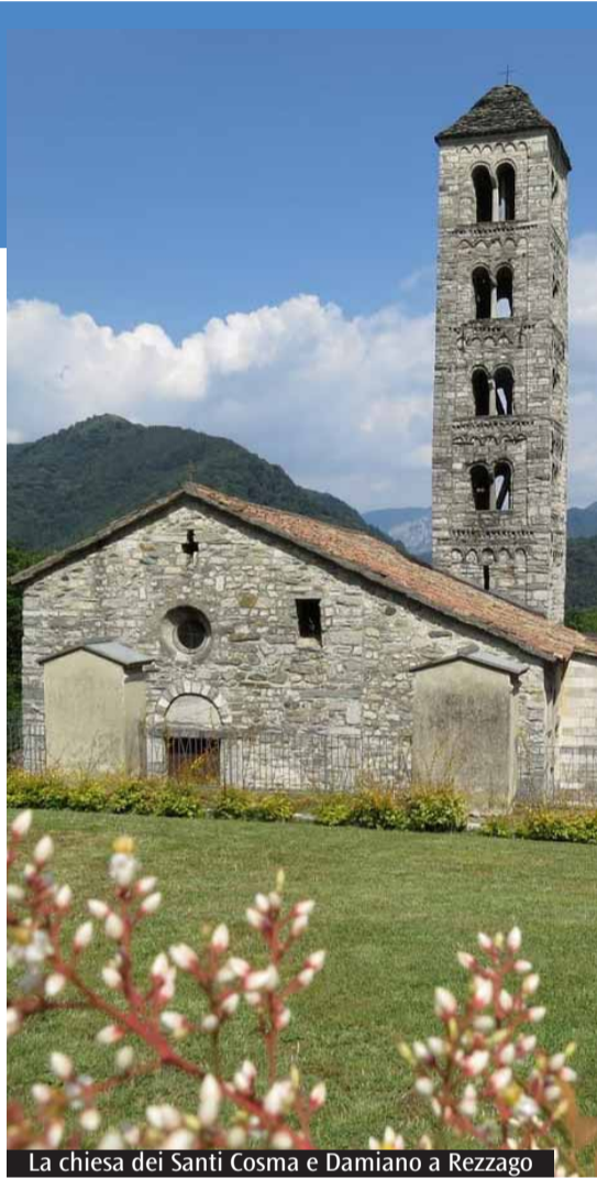
La chiesa dei Santi Cosma e Damiano a Rezzago
